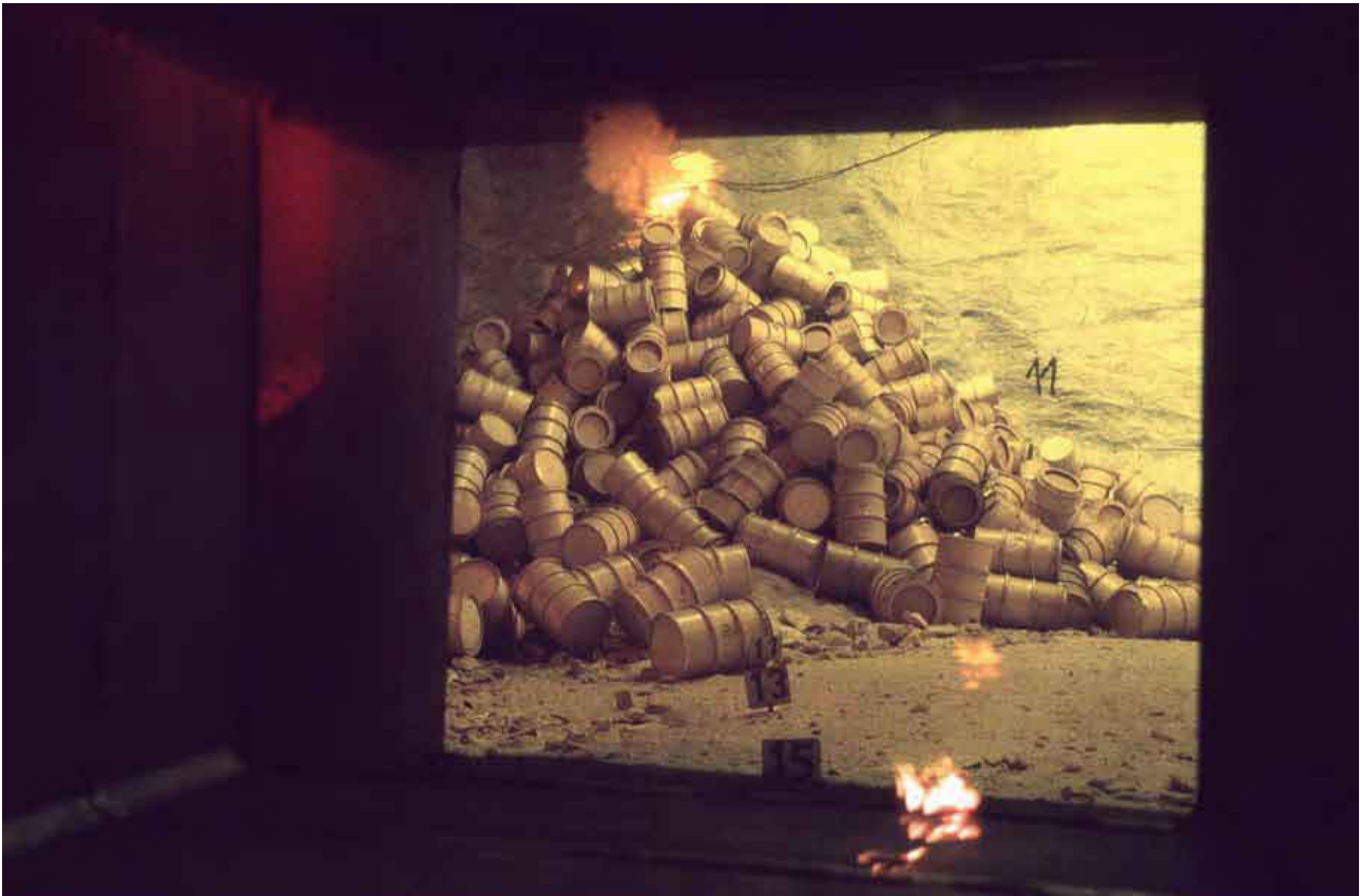
Abbildung 3: Foto der eingelagerten Gebinde, aufgenommen durch das Bleiglasfenster der Strahlenschutzmauer auf der 511-m-Sohle (April 1984)
