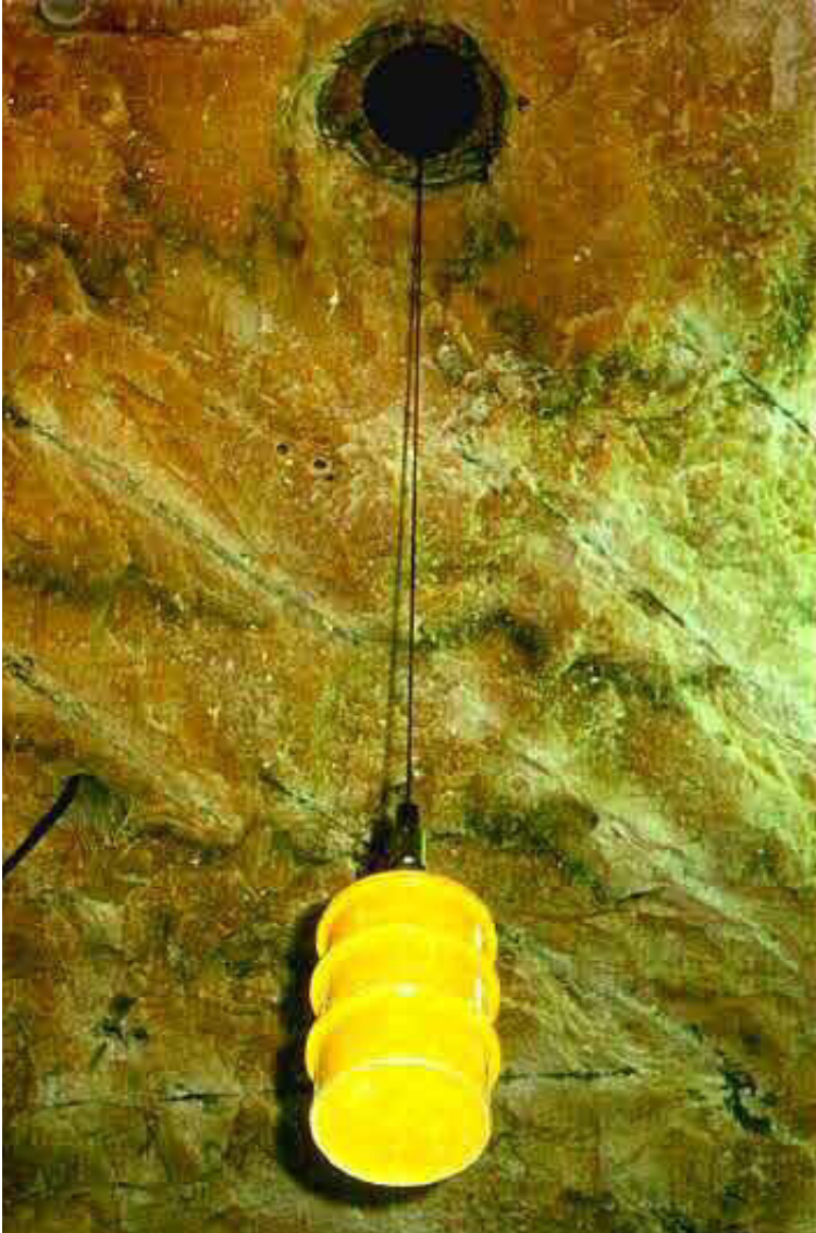
Abbildung 2: Ablassen eines 200-l-Rollreifenfassens durch die Beschickungsöffnung in der Schwebel zwischen ELK 8a/511 und der Beschickungskammer auf der 490-m-Sohle (In-situ-Test im Vorfeld der Einlagerung)
